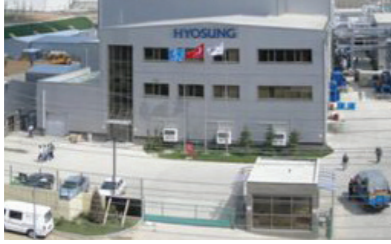
Hyosung Çerkezköy İplik Fabrikası
